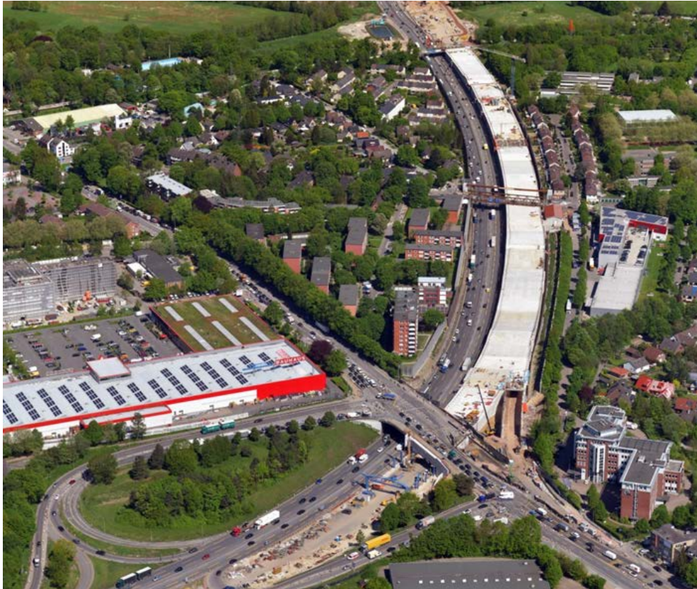
Autobahn-Ausbau und -Überdeckung im dichten Siedlungsgebiet
