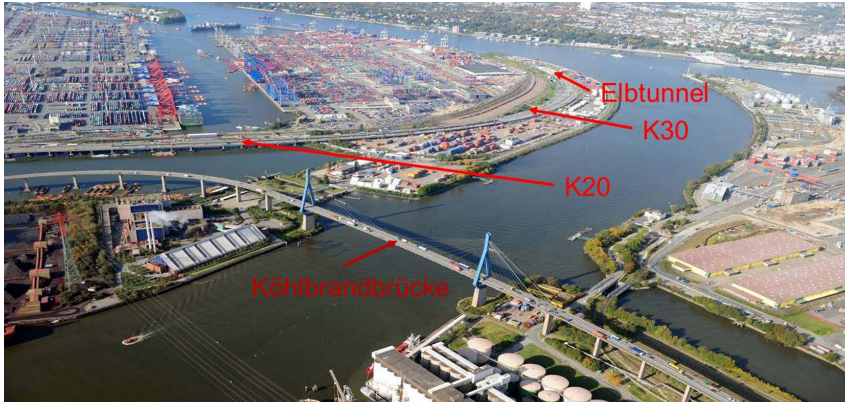
Ausbau der Verkehrsinfrastruktur im Hafen
